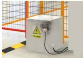
插头漏电冒火星
